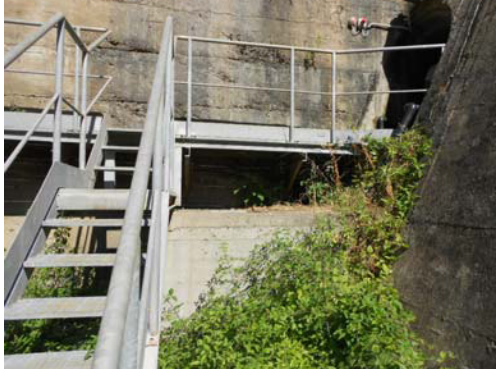
INTERVENTO 21 UBICAZIONE - Pozzetto misura ingresso concio 3 INTERVENTO - Realizzazione ballatoio
