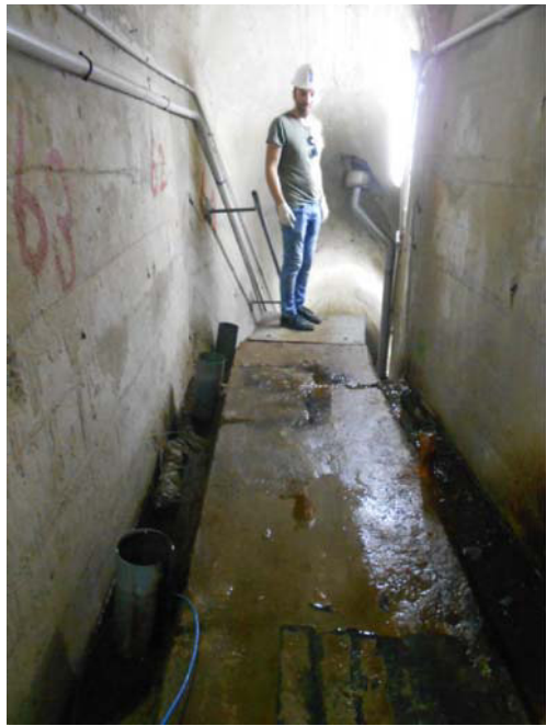
INTERVENTO 10 UBICAZIONE - Camminamenti Cunicolo e area pendoli INTERVENTO - Posa di grigliati su cls esistente
