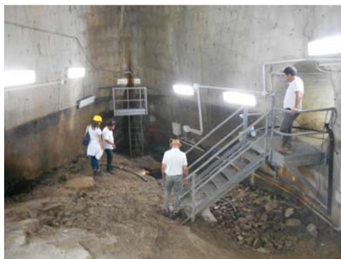
INTERVENTO 7 UBICAZIONE - Vano interno concio 1 INTERVENTO - Realizzazione passerelle e scale per accesso a zona misure
