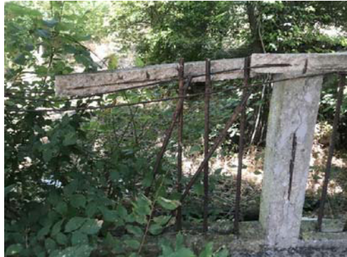
INTERVENTO 18 UBICAZIONE - Casa di guardia INTERVENTO - Rifacimento recinzione in c.a. e pannelli grigliati e cancello per accesso carrabile
