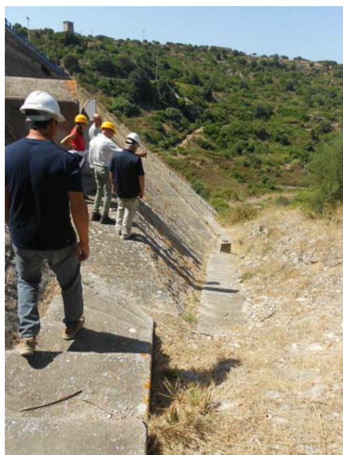
INTERVENTO 1 UBICAZIONE - Paramento valle sommità INTERVENTO - Protezione con balastra fino a ingresso cunicolo
