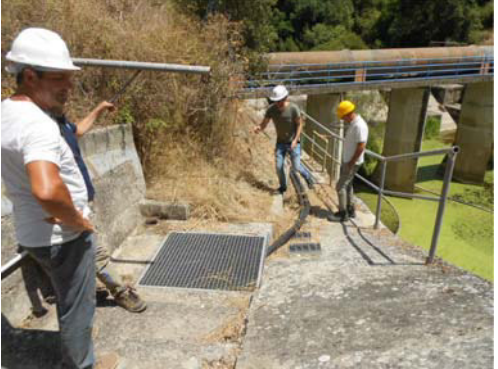
INTERVENTO 4 UBICAZIONE - Pozzetto misurazione perdite INTERVENTO - Piano in c.a. su pavimentazione esistente
