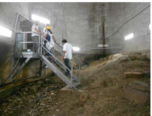
INTERVENTO 10 UBICAZIONE - Concio 3 INTERVENTO - Passerelle per accesso misure
