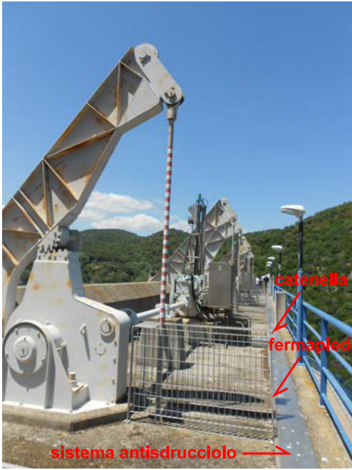
INTERVENTO 1 UBICAZIONE - Canala di bordo vano organi di manovra INTERVENTO - Sistema antisdrucolo, catenelle di protezione e fermapiède
