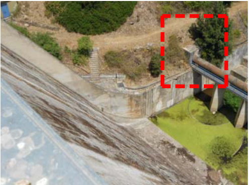
INTERVENTO 6 UBICAZIONE - Condotte pensile INTERVENTO - Realizzazione scala di accesso in carpenteria metallica
