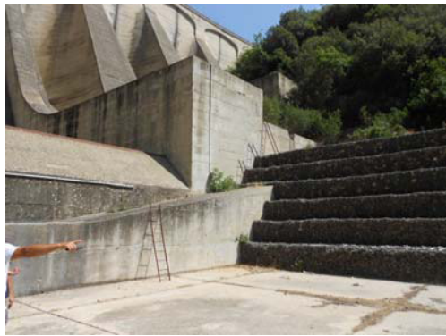
INTERVENTO 13 UBICAZIONE - Punto misure area di scarico INTERVENTO - Realizzazione scala per accesso
