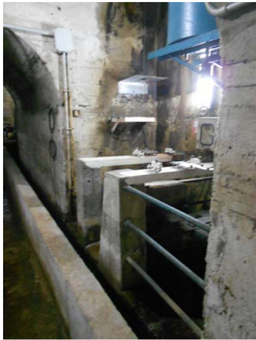
INTERVENTO 11 UBICAZIONE - Accesso al Pendolo INTERVENTO - Apertura del cordolo in c.a.
