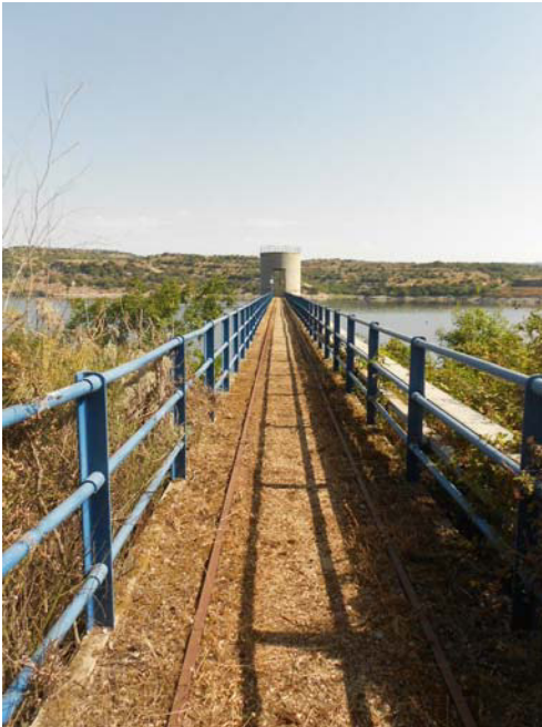
INTERVENTO 6 UBICAZIONE - Camminamento Torre di presa INTERVENTO - Ripristino parapetto e fascia fermapiade
