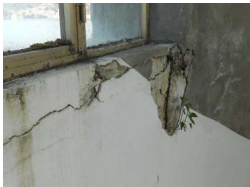
INTERVENTO 17 UBICAZIONE - Torre di presa INTERVENTO - Risanamento calcestruzzo e ferri di armatura
