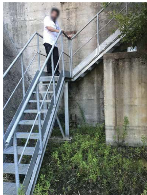
INTERVENTO 17 UBICAZIONE - Punto di misura INTERVENTO - Realizzazione accesso con nuova scala
