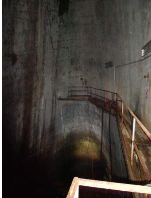
INTERVENTO 11 UBICAZIONE - Concio 4 INTERVENTO - Realizzazione scala e passerella perimetrale accesso misure
