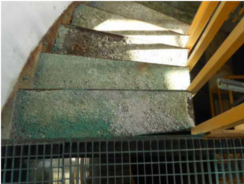
INTERVENTO 7 UBICAZIONE - Torre di presa INTERVENTO - Ripristino pedate metalliche
