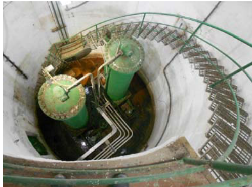
INTERVENTO 15 UBICAZIONE - Scarico di fondo INTERVENTO - Manutenzione scala pedate, parapetto e solai
