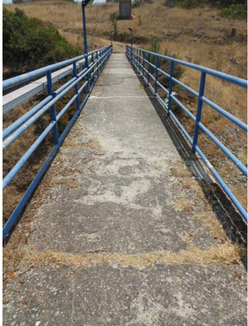
INTERVENTO 1 UBICAZIONE - Coronamento INTERVENTO - Manutenzione parapetto e pavimento
