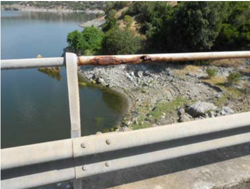
INTERVENTO 8 UBICAZIONE - Coronamento diga INTERVENTO - Sostituzione correnti parapetto
