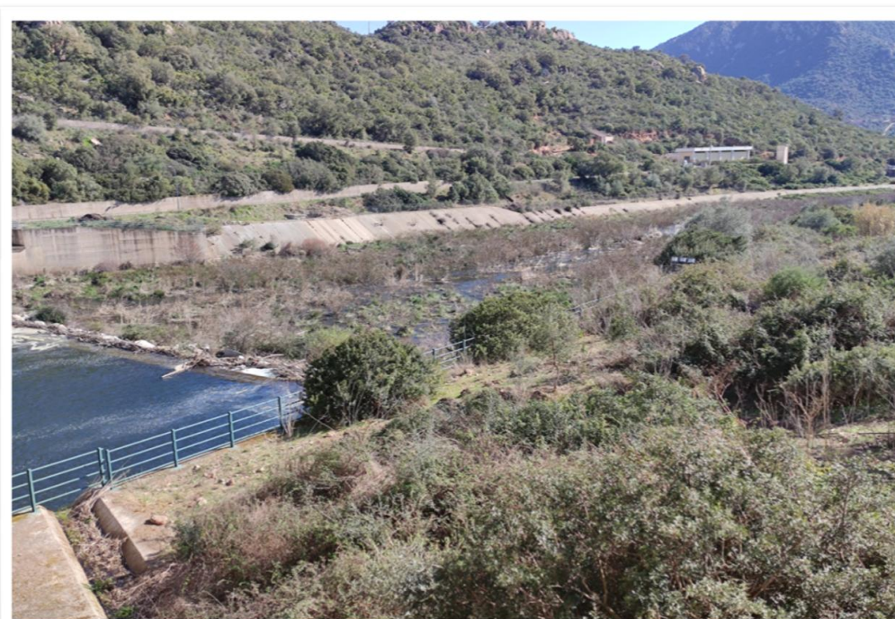
Area a valle della vasca di dissipazione Estirpazione della vegetazione, taglio di arbusti e alberi presenti nell'alveo
