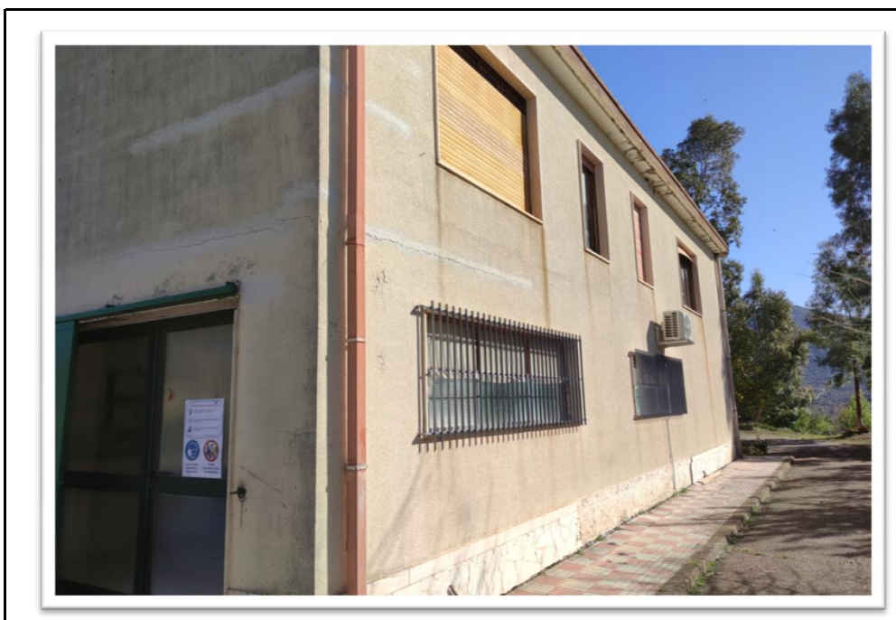
Vista su prospetto lato OVEST lavorazioni risanamento intonaci e tinteggiature facciate, risanamento di calcestruzzo e ferri di armatura tinteggiature (100%)
