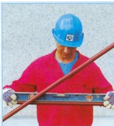
5 Verifica planarità della struttura
