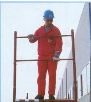
7 Inserimento dei parapetti laterali
