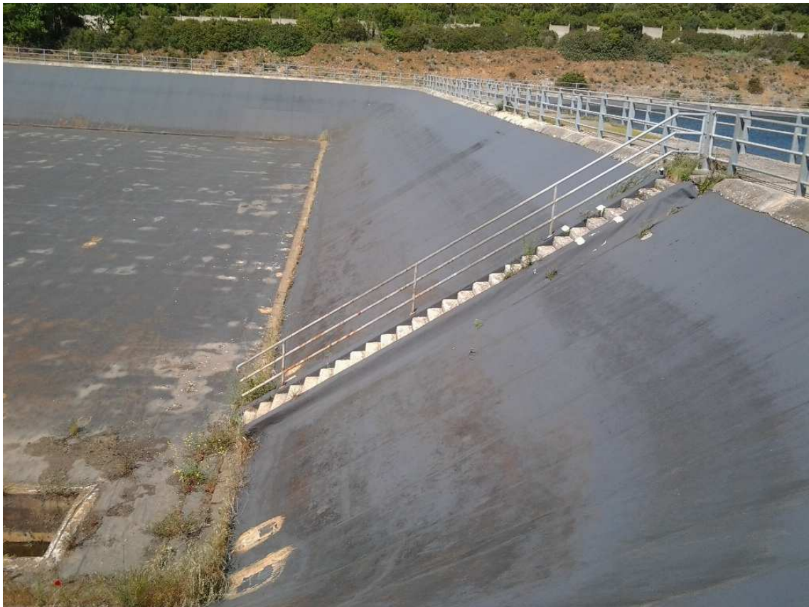
in alto: vasca n. 1, scale di accesso alle vasche (da ripristinare) e parapetti da smontare e rimontare a seguito della realizzazione del manto di impermeabilizzazione
