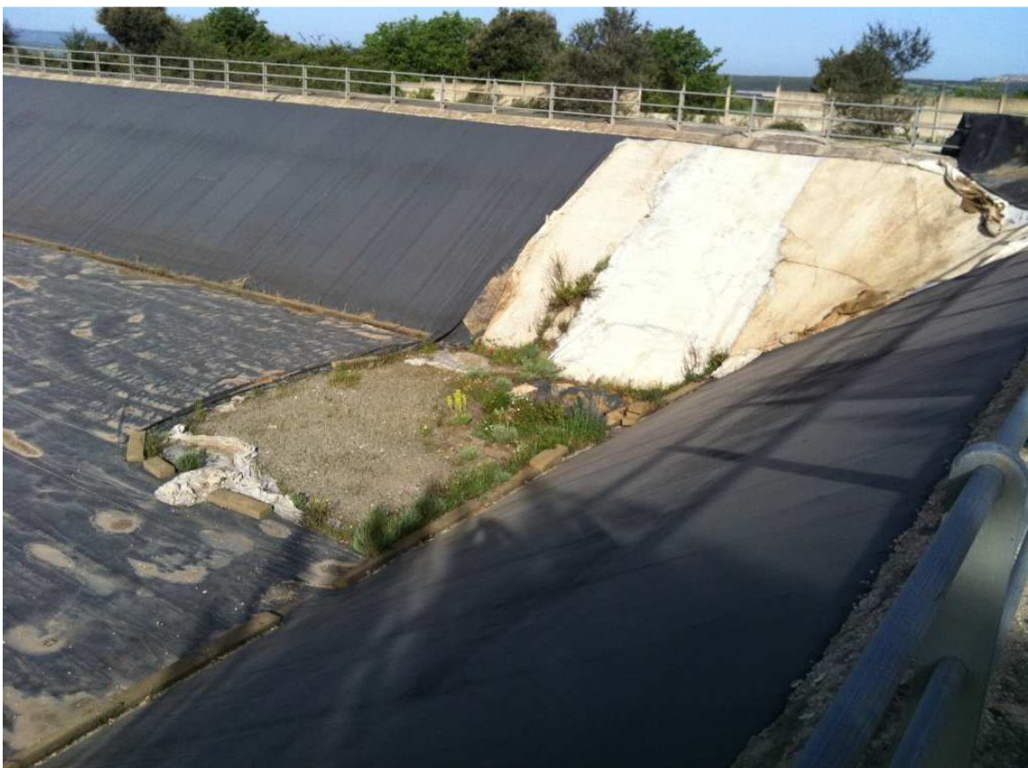
in basso: vasca n. 1, particolare del manto di impermeabilizzazione da sostituire totalmente
