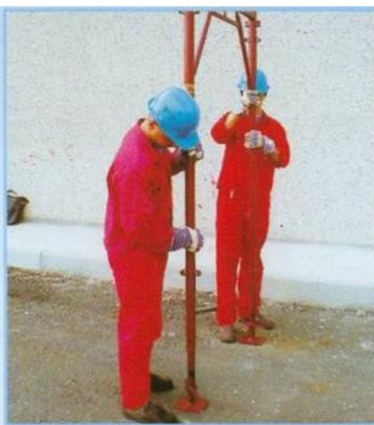
2 Inserimento del telaio sulle basette
