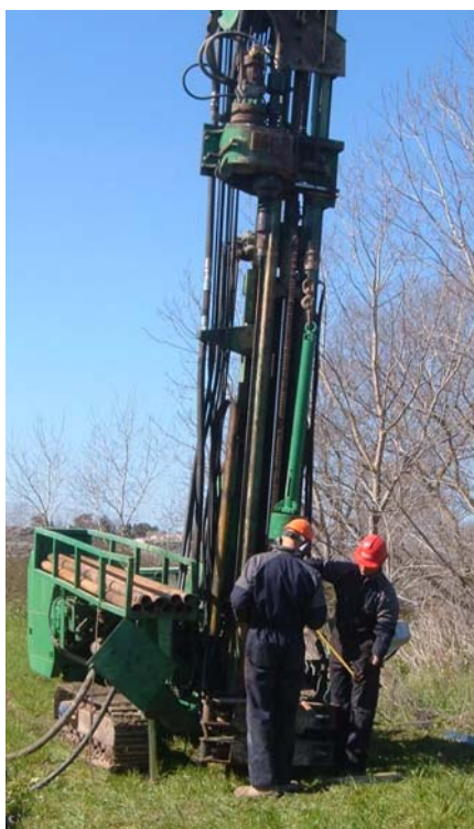
Figura 5. A sinistra (5a), fase di esecuzione del sondaggio S1 in dx idraulica; a destra (5b), esecuzione del pozzetto in corrispondenza del blocco di ancoraggio in sx idraulica.
