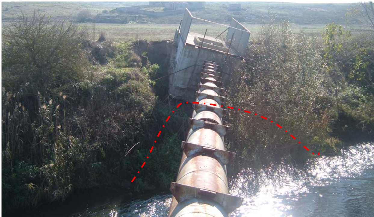
Figura 3. Stato attuale del blocco in dx idraulica: evidente il basculamento e la nicchia di erosione (in rosso) alla base della fondazione.
