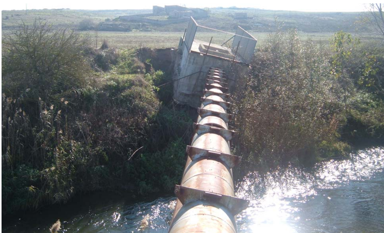
Figura 3. Stato attuale del blocco in dx idraulica: evidente il basculamento e l'area erosa alla base della fondazione.
