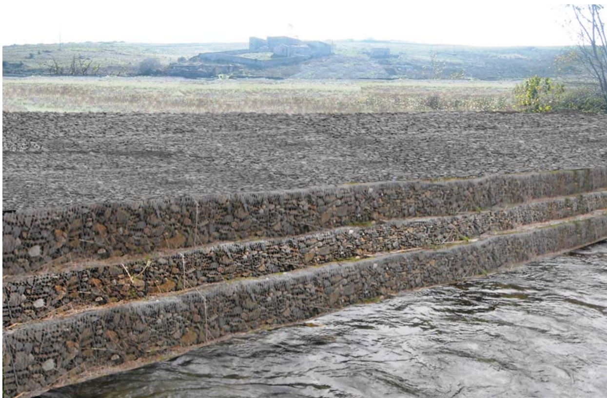
Figura 28. Vista ex-post con l'attraversamento sub-alveo e la risistemazione idraulica della sponda in dissesto.
