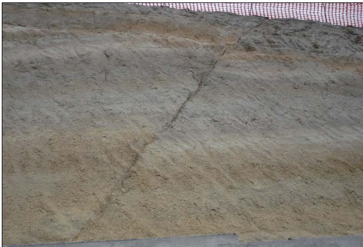
Foto 2 – Parete rocciosa in tufi pomiceo-cineritici attraversati da una faglia (zona SS 131 DCN)
