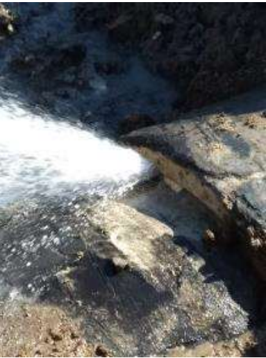
Perdita tipo su giunto tubo DN 1400
