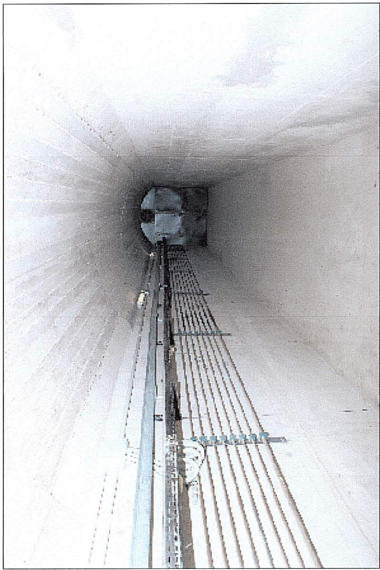
PRIMO TRATTO CUNCOLO DI ACCESSO, CON VISTA TUBAZIONI OLEODINAMICHE E CANALINA ESISTENTE IN ACCIAIO INOX ESISTENTI
