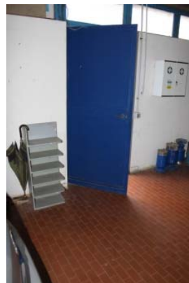
Foto 2 Porta di emergenza non a norma
