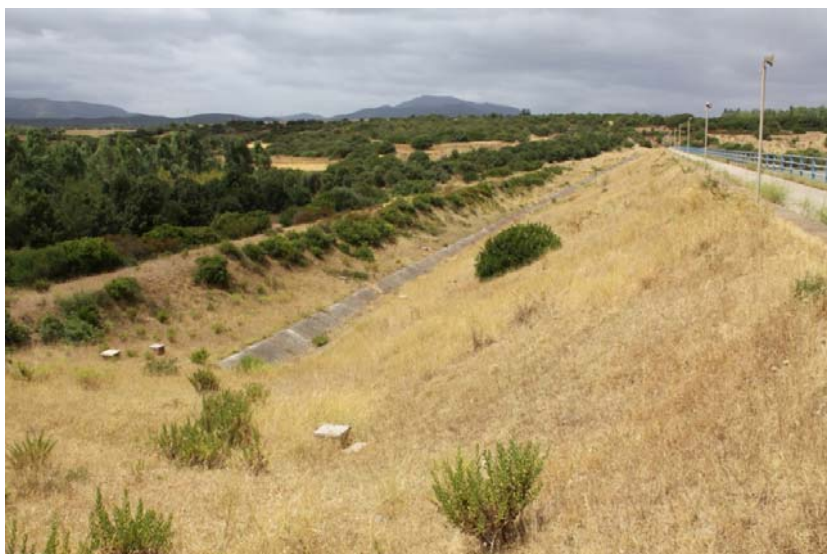
Figura 12. 7E.S1.O2 - Camminamento rete di dreno diga secondaria n°3
