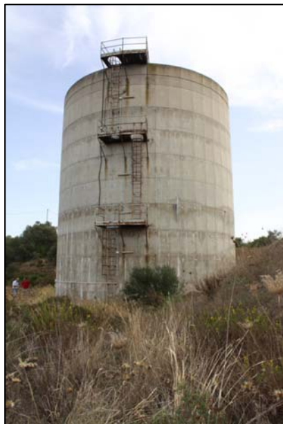
Figura 5. Torrino piezometrico Acquedotto Industriale
