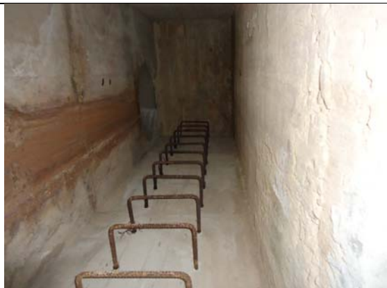
Foto 11 Scala a pioli ubicata nel tratto terminale del cunicolo
