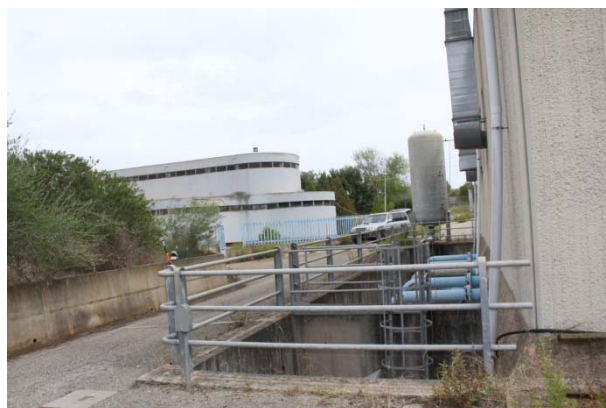
Foto 3 Parapetto esterno privo di fermapiède
