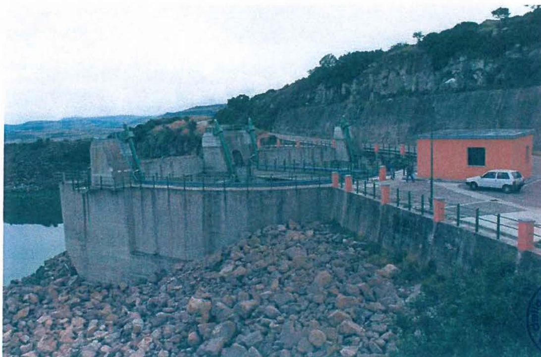
Foto n. 6: Scarico di superficie
