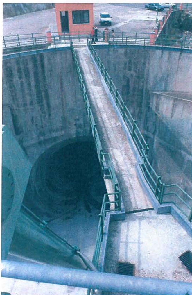
Foto n. 10: Scarico di superficie. Imbocco della galleria di scarico
