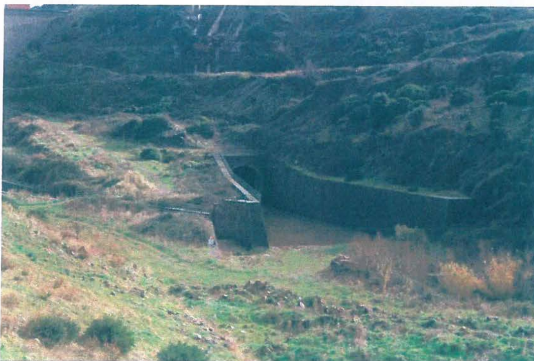
Foto n. 12: Particolare dello sbocco dello scarico di superficie e del canale fuggatore dello scarico di fondo
