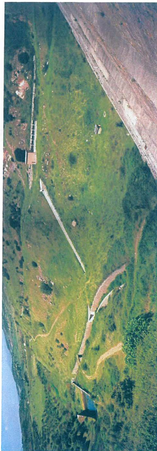
Foto n. 11: Alveo a valle della diga visto dal coronamento. Si notano, da sinistra: lo sbocco dello scarico di superficie; il canale fuggatore dello scarico di fondo; lo scarico di alleggerimento; il canale adduttore
