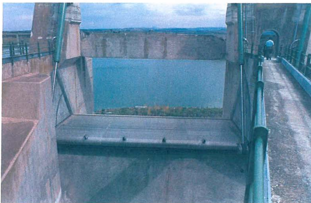
Foto n. 9: Scarico di superficie. Paratoia aperta
