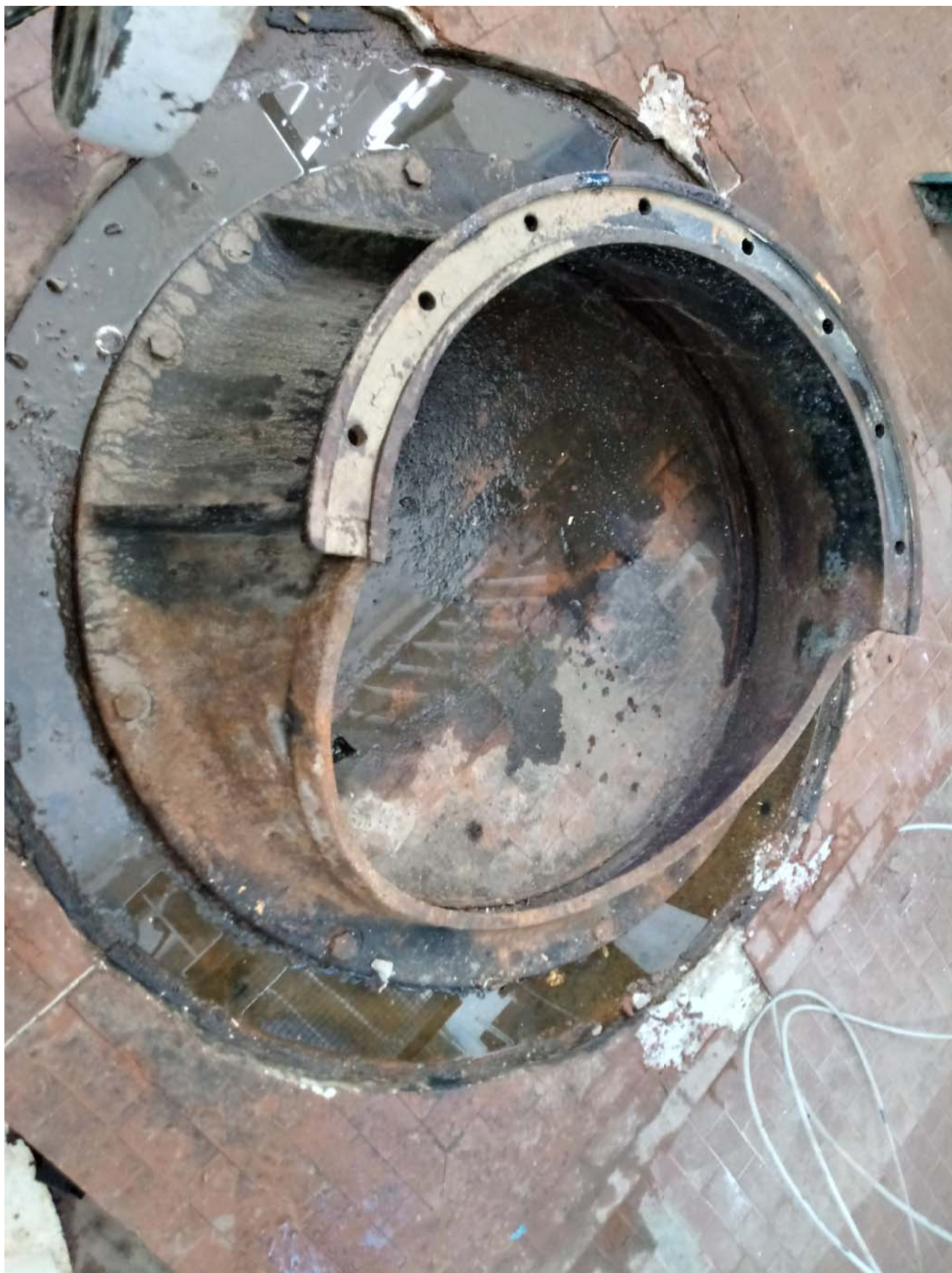
Figura 6: Particolare basamento pompa su fondazione scoperta
