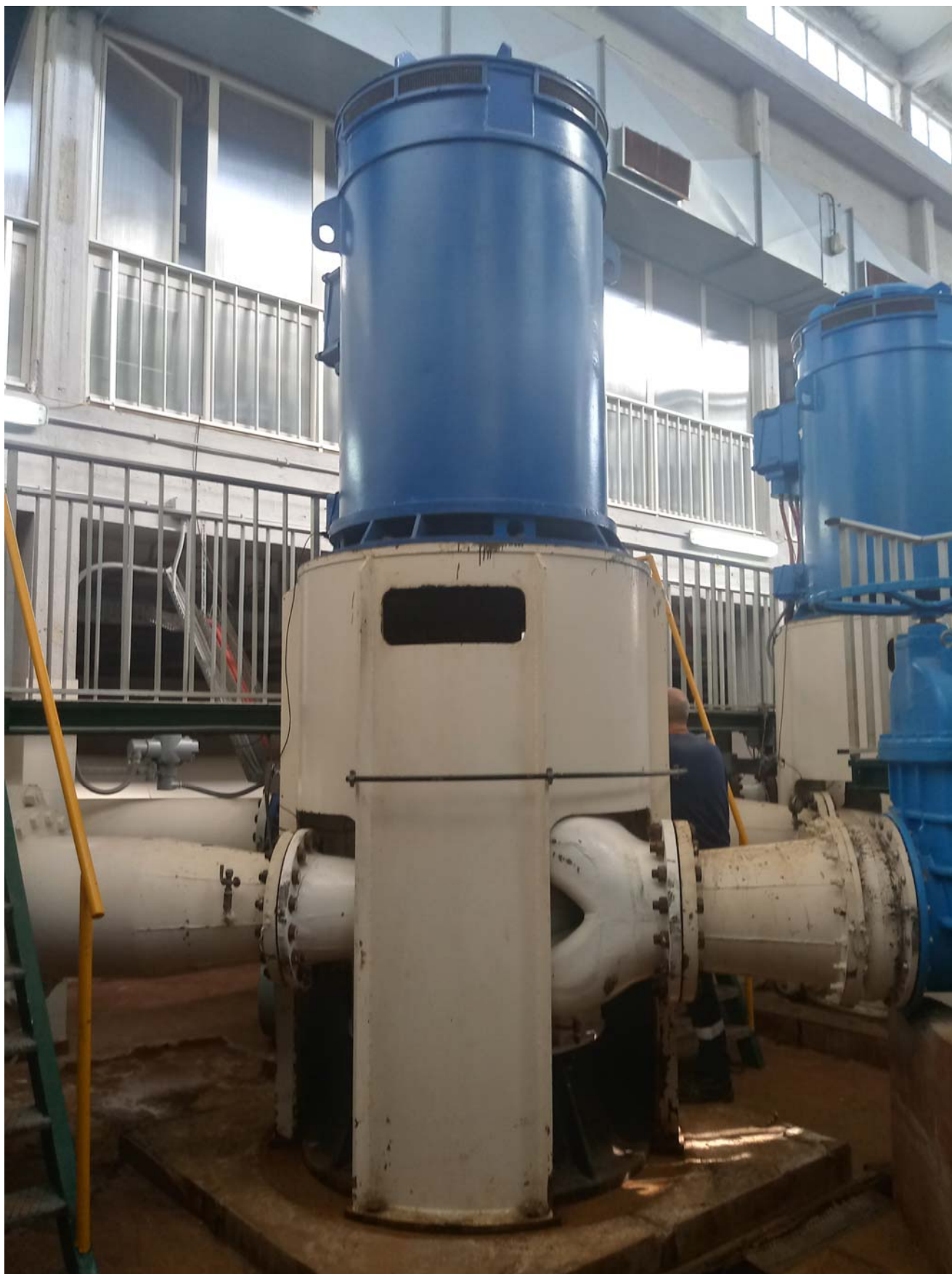
Figura 2: Prospetto sistema pompa motore in configurazione d'uso attuale
