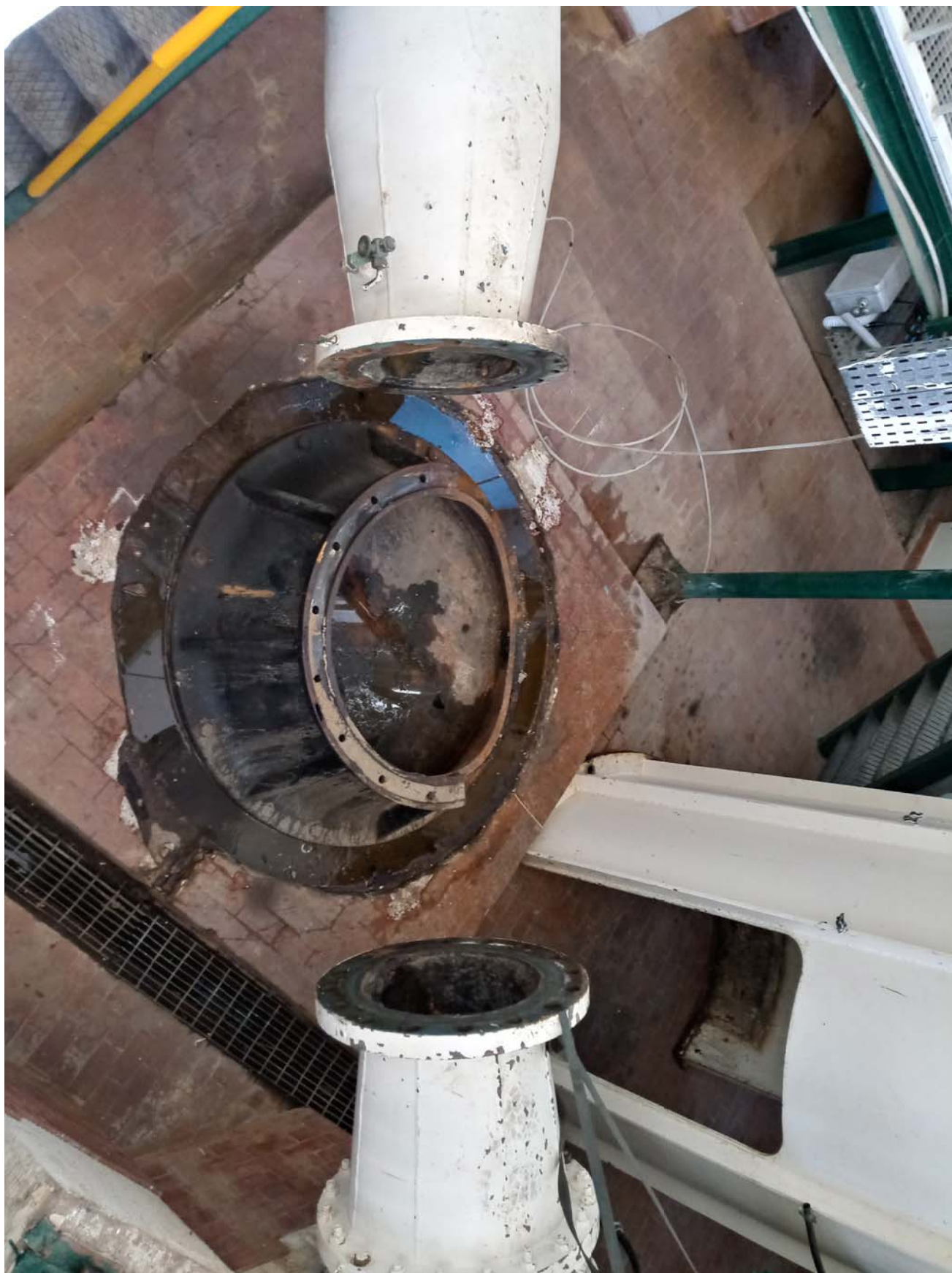
Figura 5: Particolare basamento pompa su fondazione scoperta e connessioni flangiate di aspirazione (dx) e mandata (sx)
