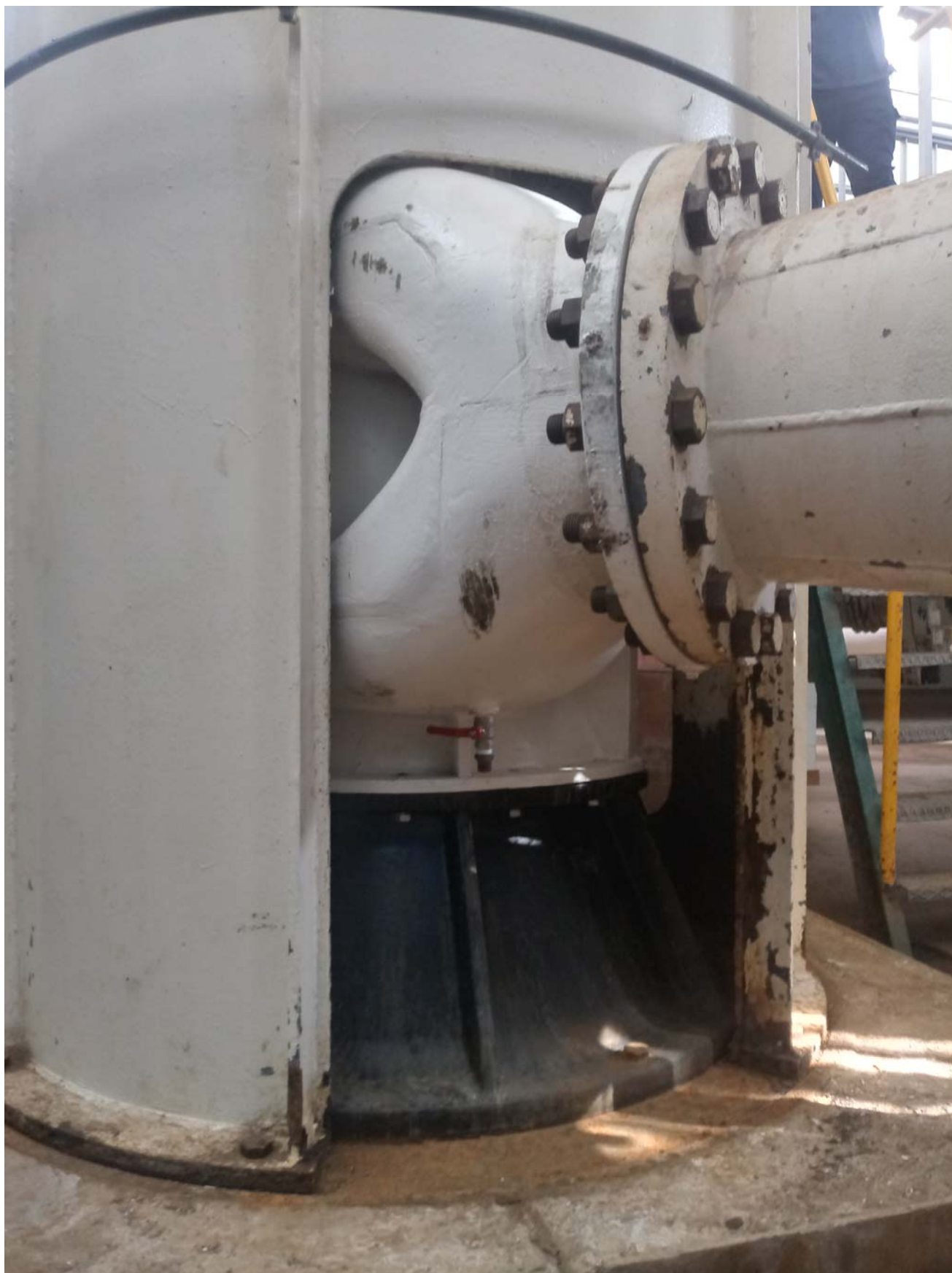
Figura 3: Particolare connessione su aspirazione e basamento pompa
