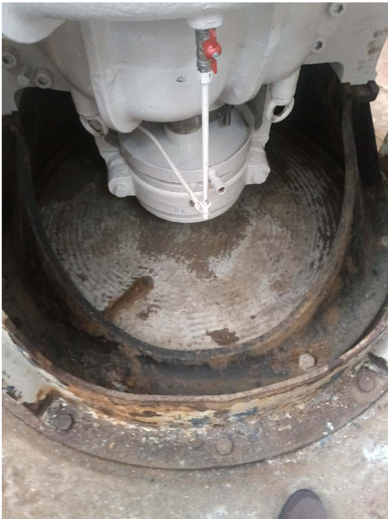
Figura 4: Particolare basamento pompa e cuscinetto
