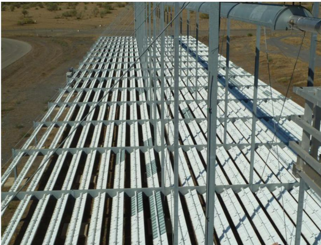
Figura 9 – Collettore lineare Fresnel installato presso la PSA di Almeria.
